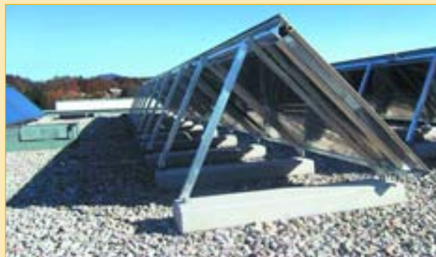
Figura 5: Colocación sobre cubierta plana y estructura auxiliar
